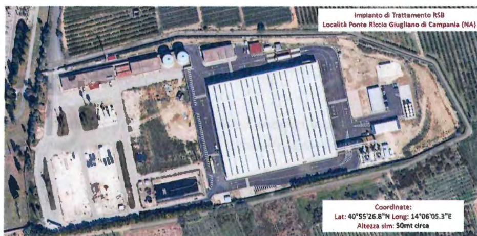
Figura n. 4: Sito IPPC di località Ponte Riccio Giugliano di Campania (NA)
