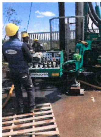
Figura n. 3 – perforazione pozzo TW1
