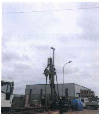
Figura n. 2 – perforazione piezometro MW1
