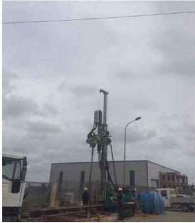
Figura n. 2 – perforazione piezometro MW1
