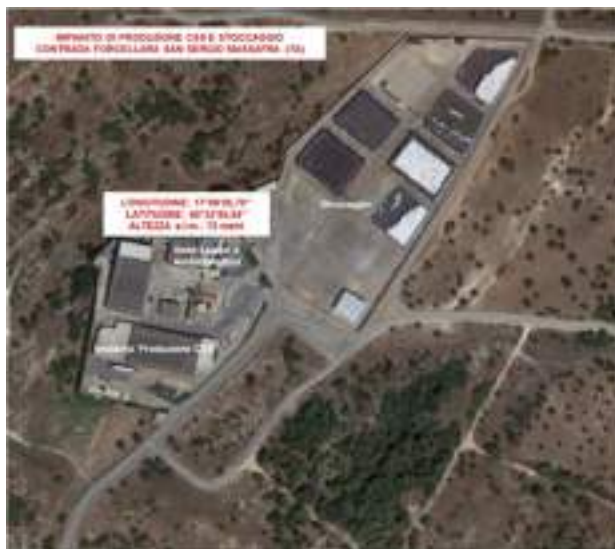
Figura n.2: Sito IPPC di contrada Forcellara San Sergio e Impianti in esso presenti.
