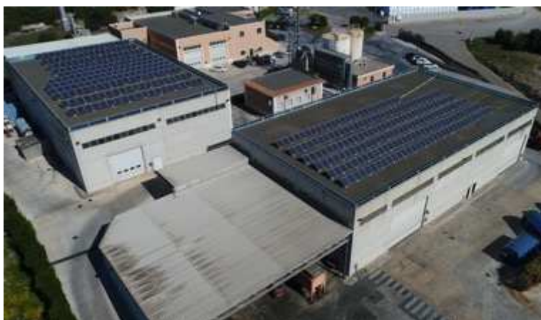
Figura n. 9: Impianto fotovoltaico sito in Massafra alla contrada Forcellara San Sergio.
