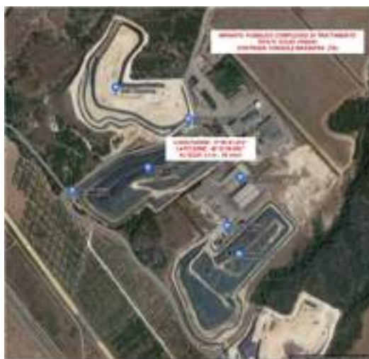
Figura n. 1: Sito IPPC di Contrada Console e impianti presenti
