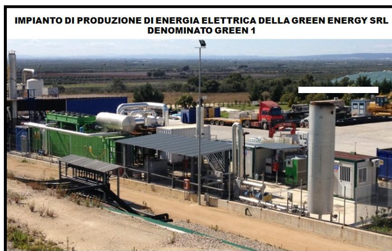
Figura n. 2: Vista dall'alto dell'Impianto di produzione di energia elettrica della Green Energy srl denominato GREEN 1, contrada "Console" - Massafra (TA).
