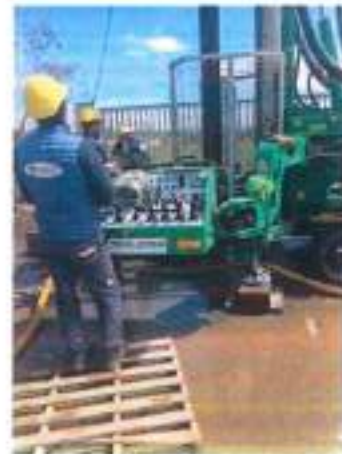
Figura n. 3 – perforazione pozzo TW1
