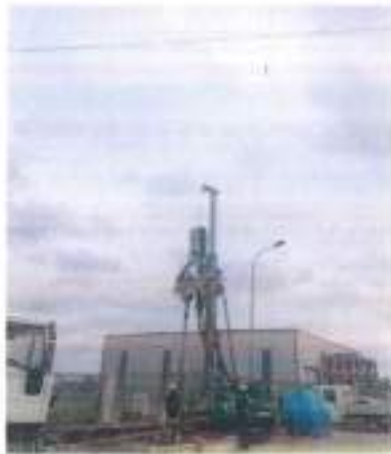
Figura n. 2 – perforazione piezometro MW1
