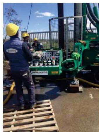
Figura n. 3 – perforazione pozzo TW1
