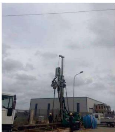
Figura n. 2 – perforazione piezometro MW1
