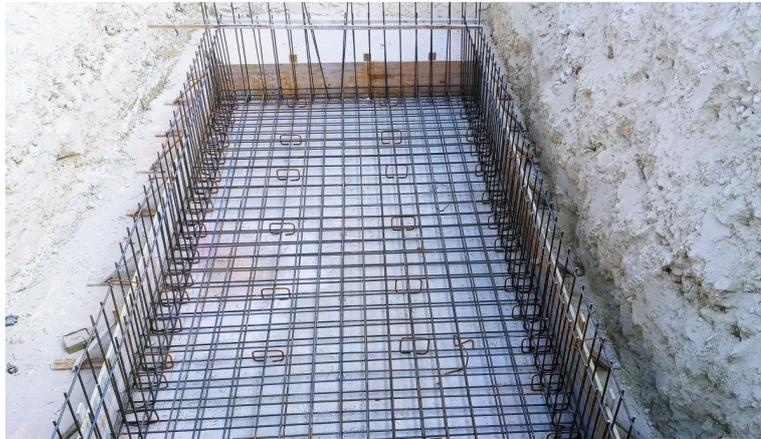
Figura n. 5a: Fase di realizzazione impianto di trattamento acque di seconda pioggia. Scarico S2b.
