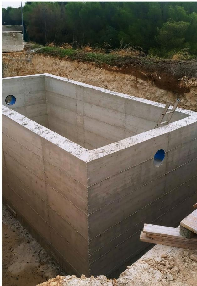
Figura n. 5b: Fase di realizzazione impianto di trattamento acque di seconda pioggia. Scarico S2b.
