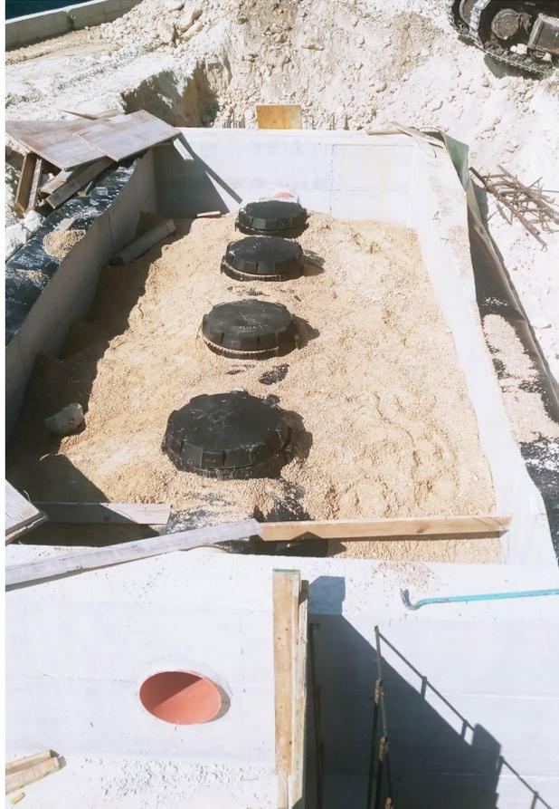
Figura n. 5c: Fase di realizzazione impianto di trattamento acque di seconda pioggia. Scarico S2b. Particolare della vasca completa di impianto di trattamento installato e posizionato nella vasca in c.a..
